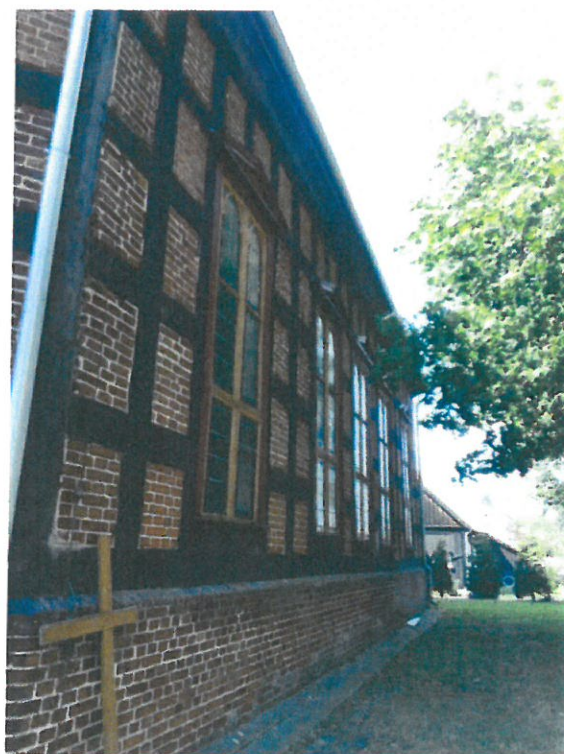
Fot.4 Elewacja wschodnia
