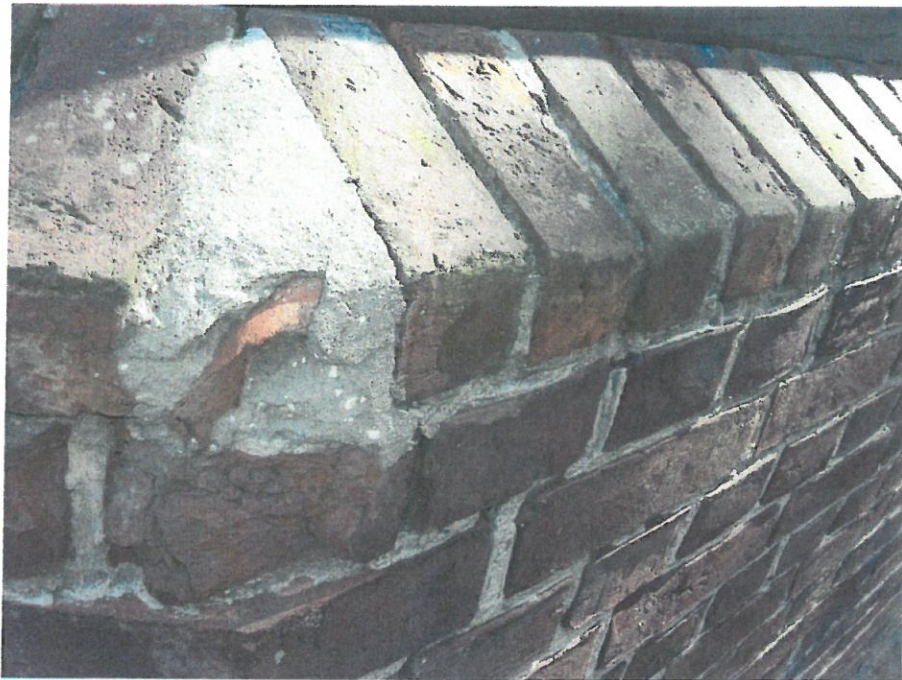
Fot. 7 Rolka cokołu- uzupełnienie brakującej kształtki zaprawą cementową
