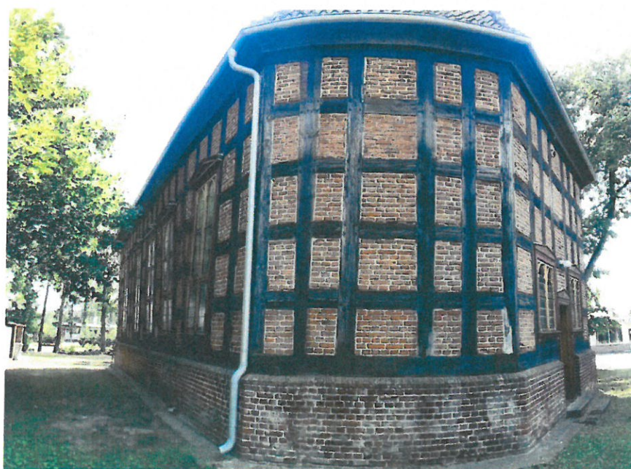
Fot.2 Elewacja północno- wschodnia
