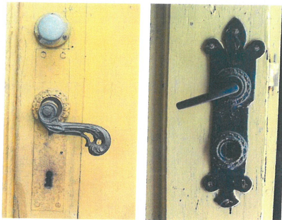
Fot. 42,43 Klamki drzwiowe zachowane w stanie dobrym
