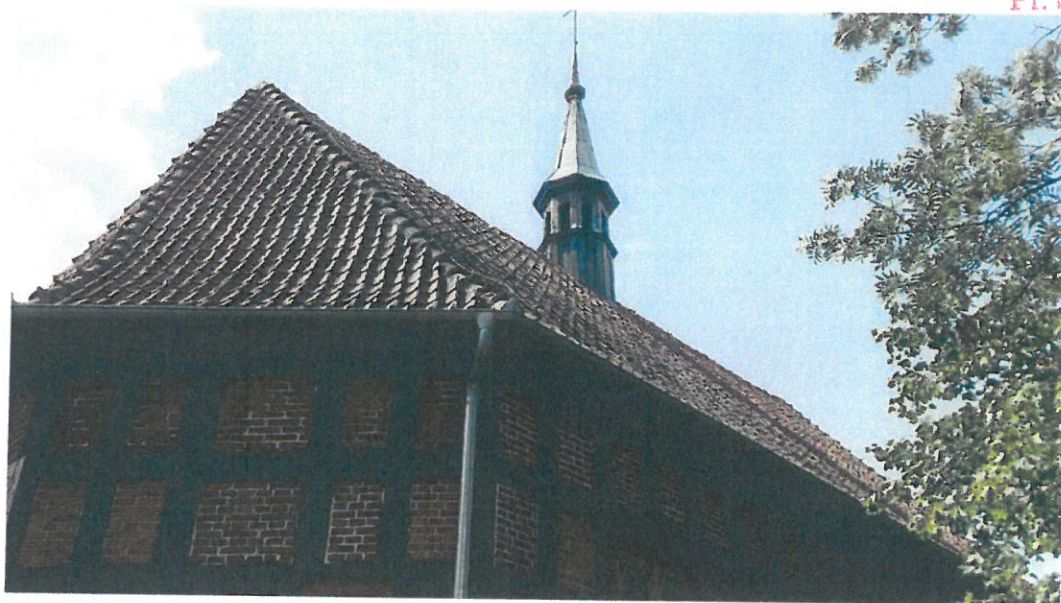
Fot. 11 Widok dachu
