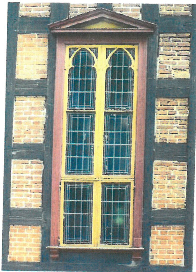
Fot. 13 Widok okna sześciopanelowego
