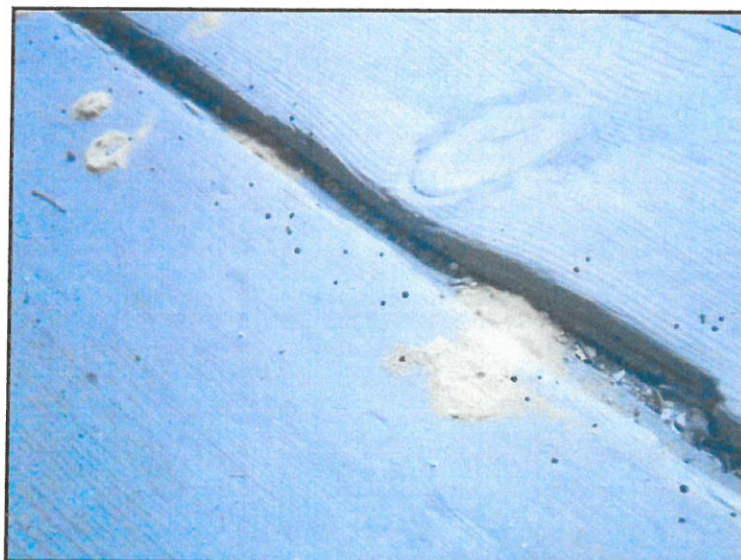
Fot. 41 Fragment drewnianej podłogi na chórze
