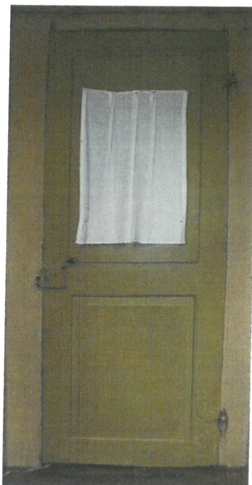
Fot. 18 Drzwi do zakrystii
