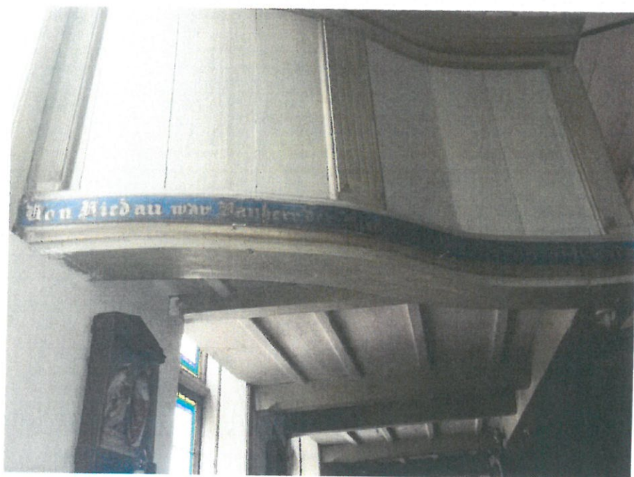
Fot. 24 Balustrada empory
