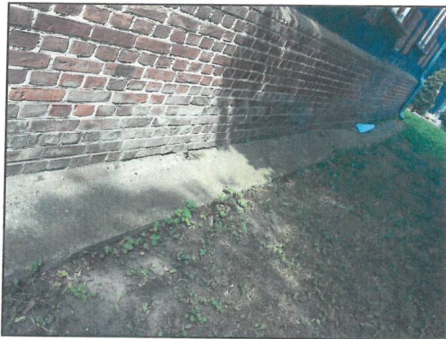
Fot. 5 Nawierzchnia po stronie wschodniej- opaska betonowa
