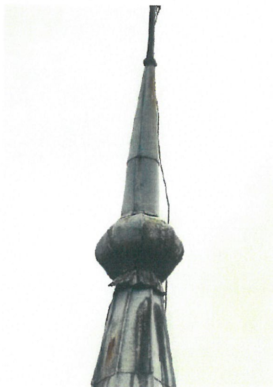
Fot. 12 Widok wieżyczki ze zbliżeniem na skorodowaną kulę i blachę
