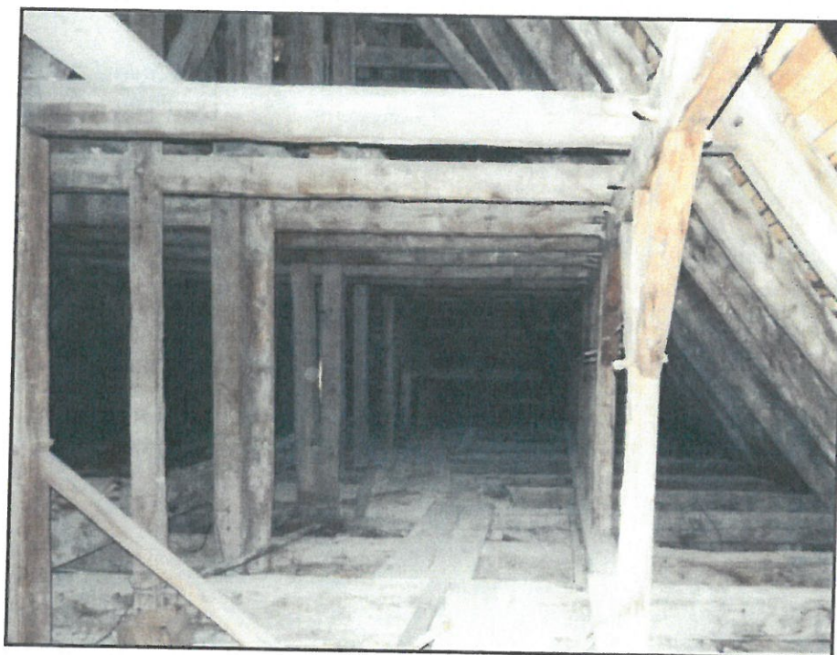
Fot. 29 Fragment konstrukcji więźby dachowej- widok ogólny
