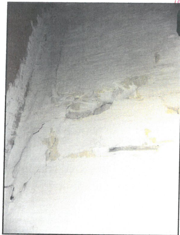
Fot. 35,36 Uszkodzenia warstw malarskich i tynkarskich wewnętrznych
