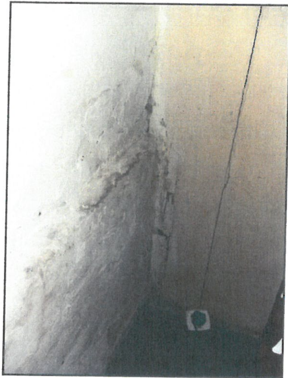
Fot. 35,36 Uszkodzenia warstw malarskich i tynkarskich wewnętrznych
