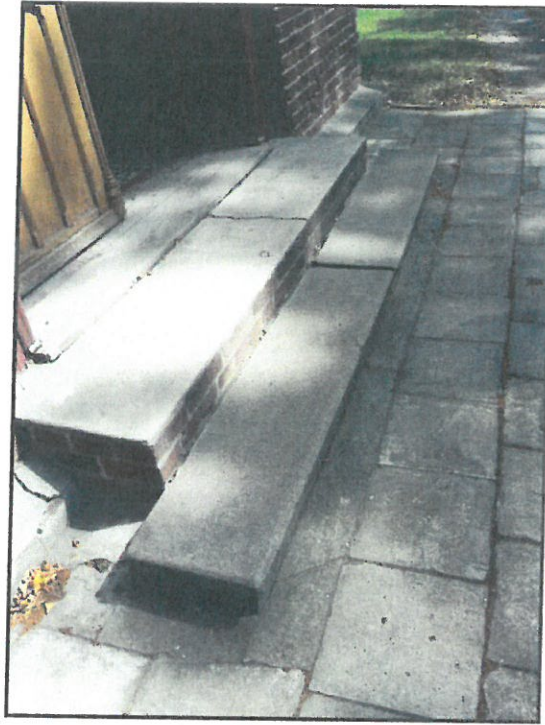
Fot. 3 Uszkodzone stopnie przed wejściem głównym do kościoła- str. południowa
