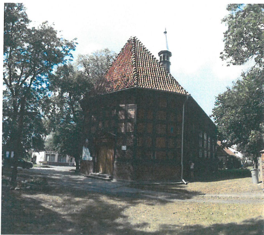
Fot. 1 Elewacja południowa
