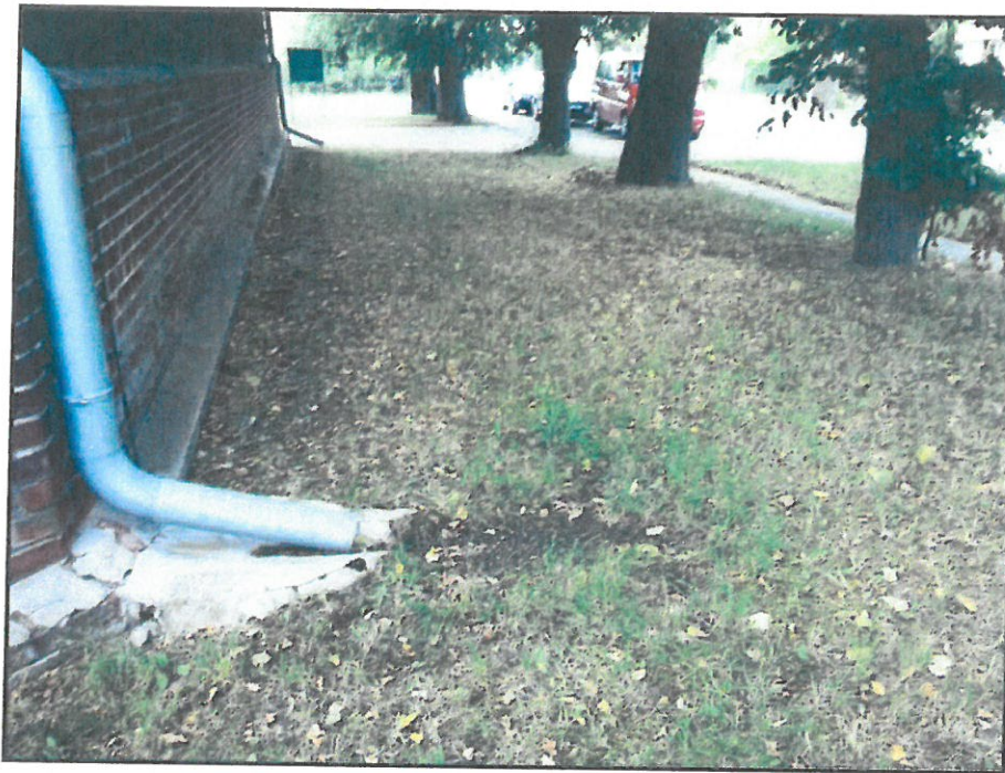
Fot. 1 Nawierzchnia po stronie zachodniej kościoła
