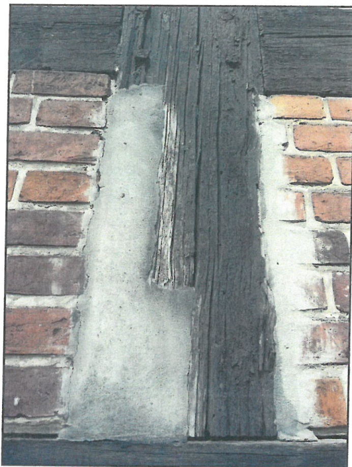
Fot. 17 Ubytek słupa uzupełniony zaprawą cementową
